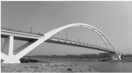
图 11 巴溪洲桥照片 Fig. 11 Picture of Ba Xi Zhou Bridge
