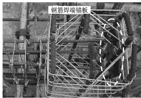
图 3 二层边节点梁上弯锚钢筋细部图
