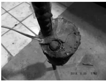
(c) 试件另一端破坏情况
