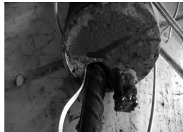
(b) 试件一端破坏情况
