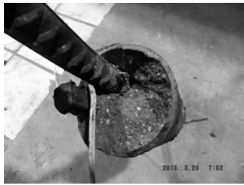
(b) 试件一端破坏情况
