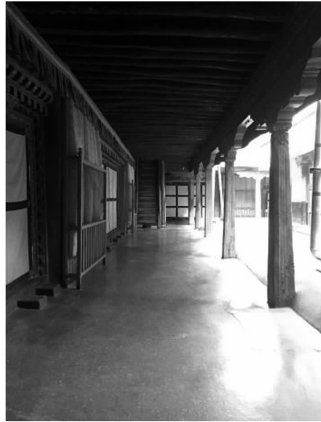
图 11 回廊排架结构
