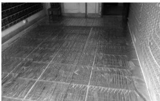
图 3 实验房间毛细管网地板敷设图
