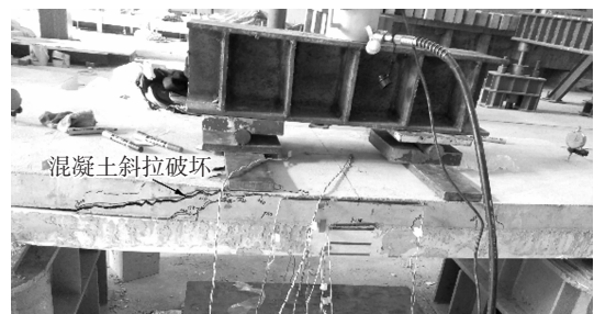
(d) 试件D5发生混凝土斜拉破坏
