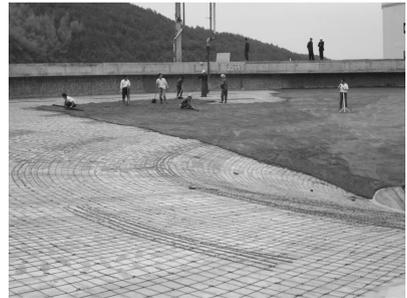
图 11 混凝土构件涂抹复合砂浆
