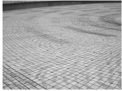
图 10 绑扎安装钢筋网
