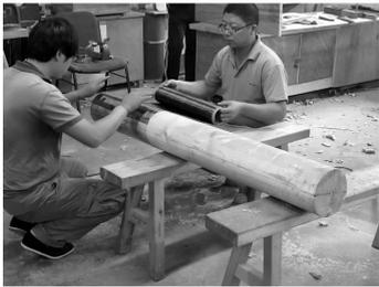
(c) CFRP 布包裹加固位置
