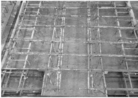
(a) 浇筑一侧预制墙片
