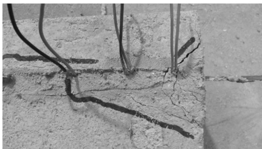
图 11 试件 C30-G40-150 混凝土斜裂缝
