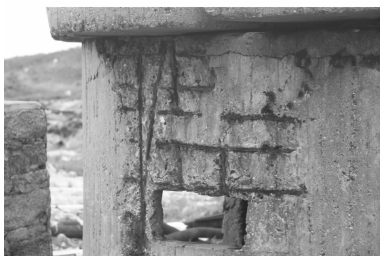
(a) 某建筑物 A 墙体
